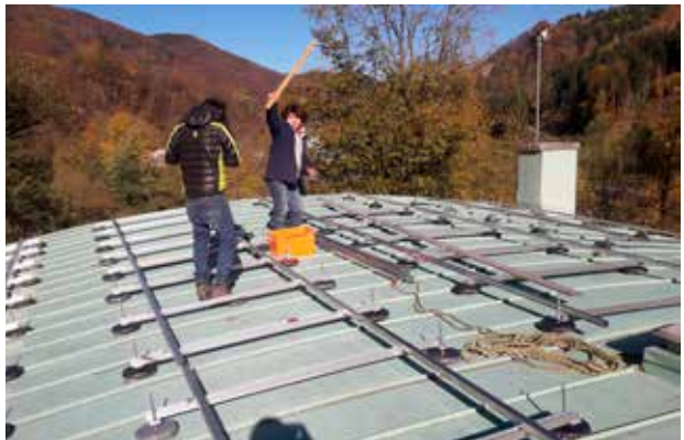
Sinan und Meliha bereiten die Photovoltaikanlage vor
