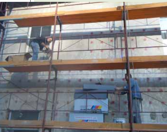
Die neue Fassade entsteht.
