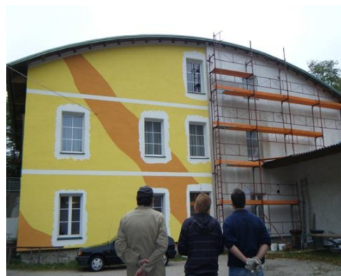
Wir haben unser eigenes Haus saniert und isoliert.
